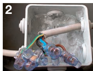
2 Effettuare il cablaggio elettrico.
